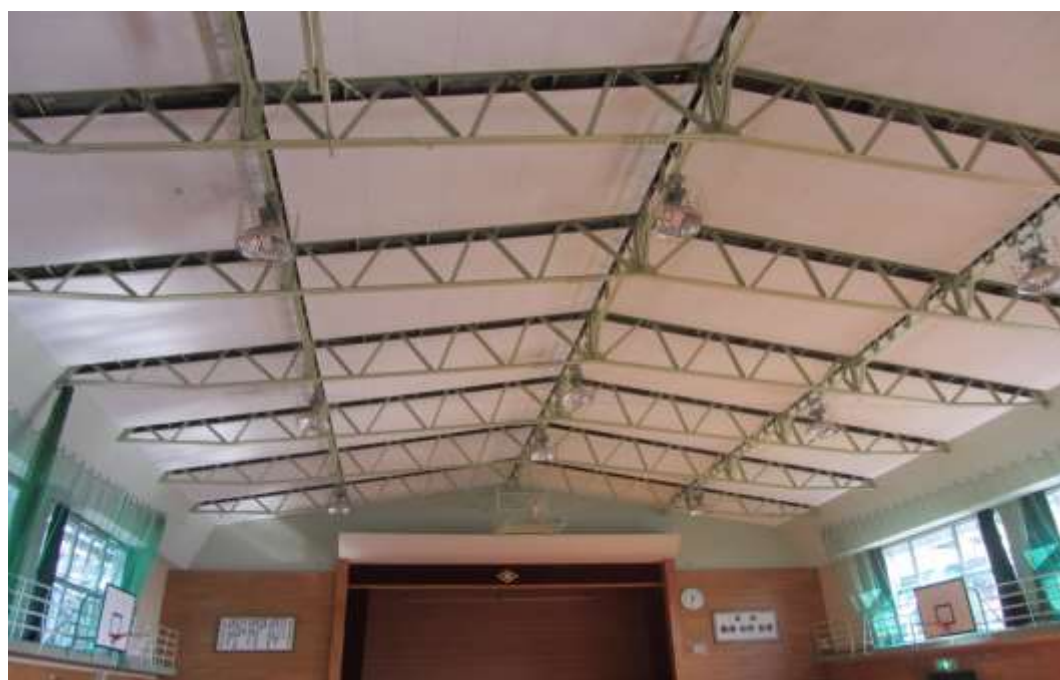
① 天井：照明などの落下物がないか確認
