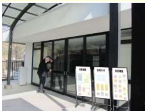
体育館 エントランス外側
