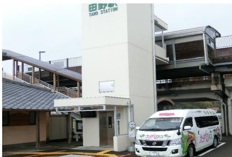
図 3.2 田野駅に設置されたエレベーター
