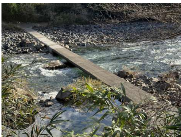
北川村未指定文化財 崎山沈下橋
