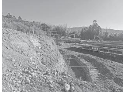
改良工事が進む高田下ノ丸線
